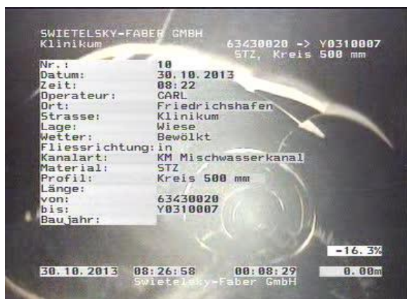
Haltung vor der Sanierung
